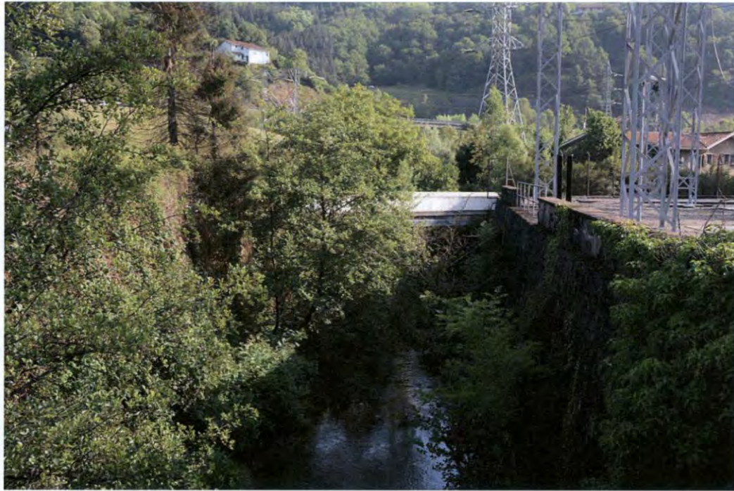
Zona de aguas abajo del puente del pk 1.008
