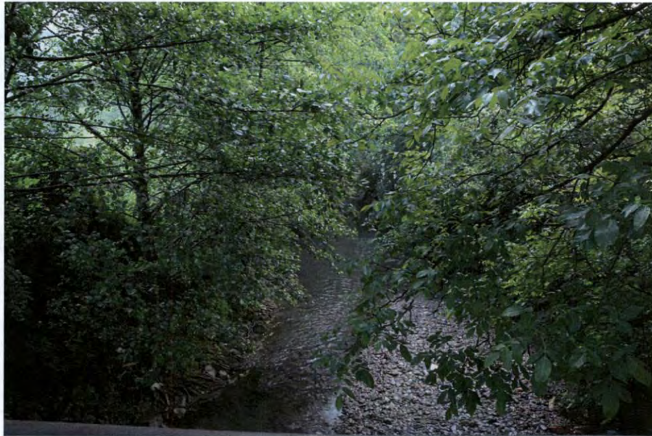
Cauce del río desde el puente pk 1.418 hacia aguas abajo
