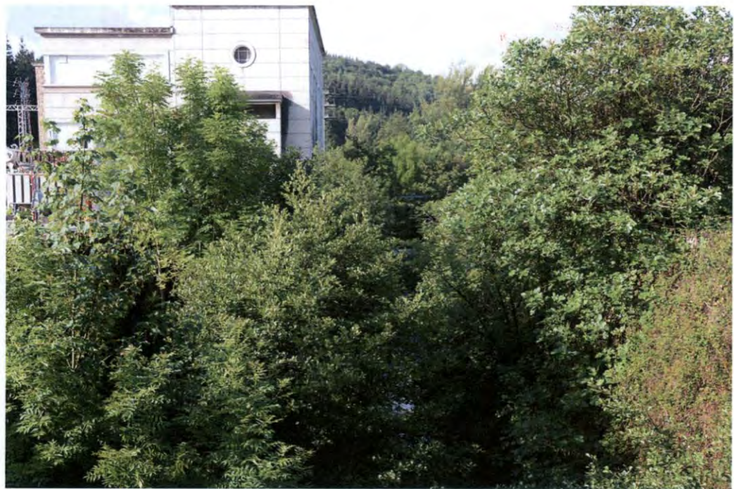
Zona de aguas arriba del puente del pk 1.020
